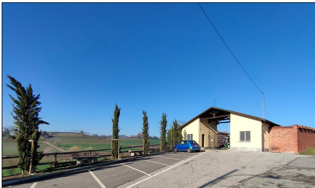
Cimitero di Airali. Edificio di ingresso e recinzione perimetrale in laterizio.
