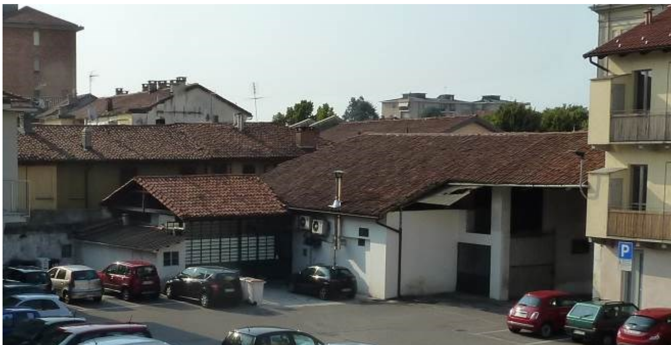
Foto 6 – l’edificio “ristorante/pizzeria” visto dalla copertura del supermercato. Stato esistente.
