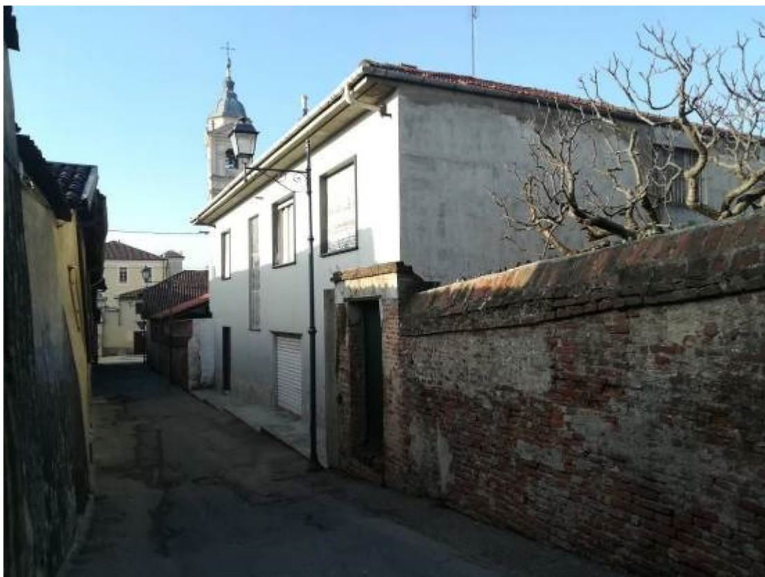
Foto 4 – vicolo Santo Stefano, edificio “villa”. Stato esistente.
