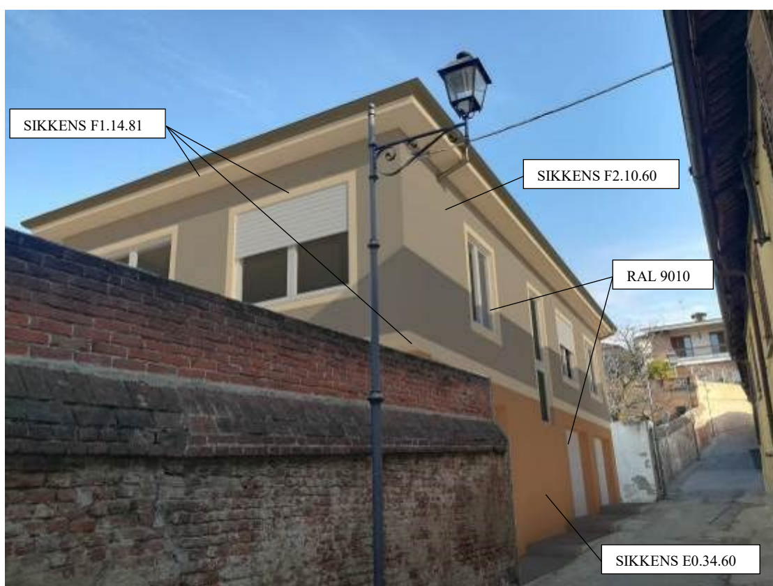
Inserimento 3 – interno cortile, edificio “villa”. Stato in progetto. Si prevede la manutenzione straordinaria dell’intero edificio. Le cromie di facciata corrispondono a quelle dell’edificio a 3 p. f. t. presente in via Vittorio Emanuele II
