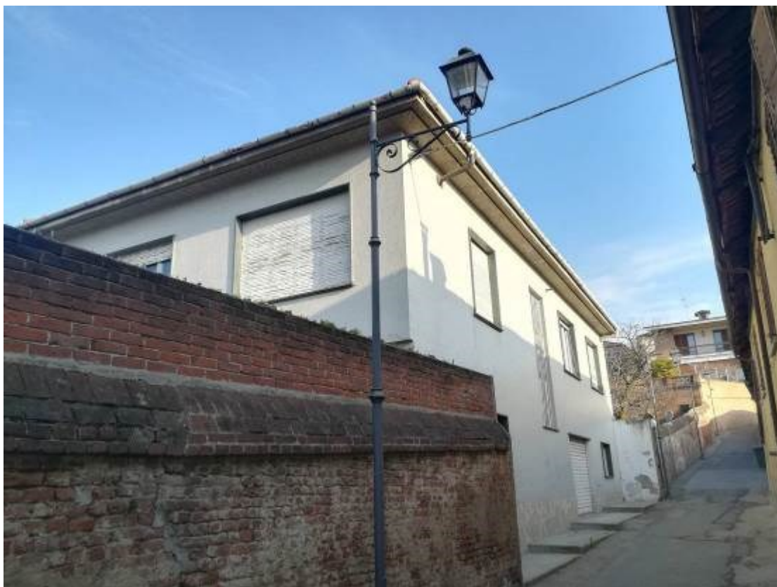
Foto 3 – vicolo Santo Stefano, edificio “villa”. Stato esistente.
