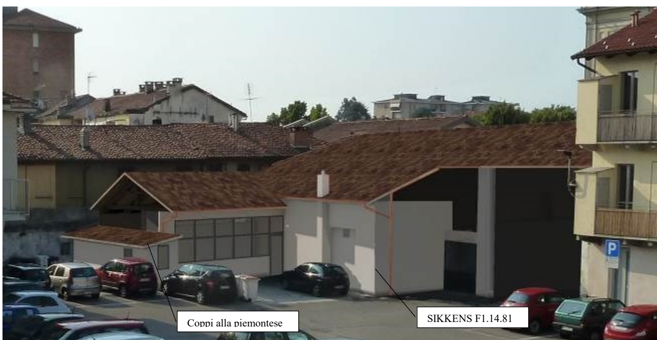
Foto 6 – l’edificio “ristorante/pizzeria” visto dalla copertura del supermercato. Stato in progetto. Si prevede il rifacimento degli intonaci, la riconfigurazione di alcune aperture, la sostituzione del manto di copertura del basso fabbricato con manto di tipo discontinuo in coppi disposti alla piemontese, la sostituzione delle faldalerie in PVC con profili in rame o lamiera preverniciata, la realizzazione di un comignolo in laterizio intonacato e tinteggiato ad occultamento della canna fumaria in acciaio inox esistente.
