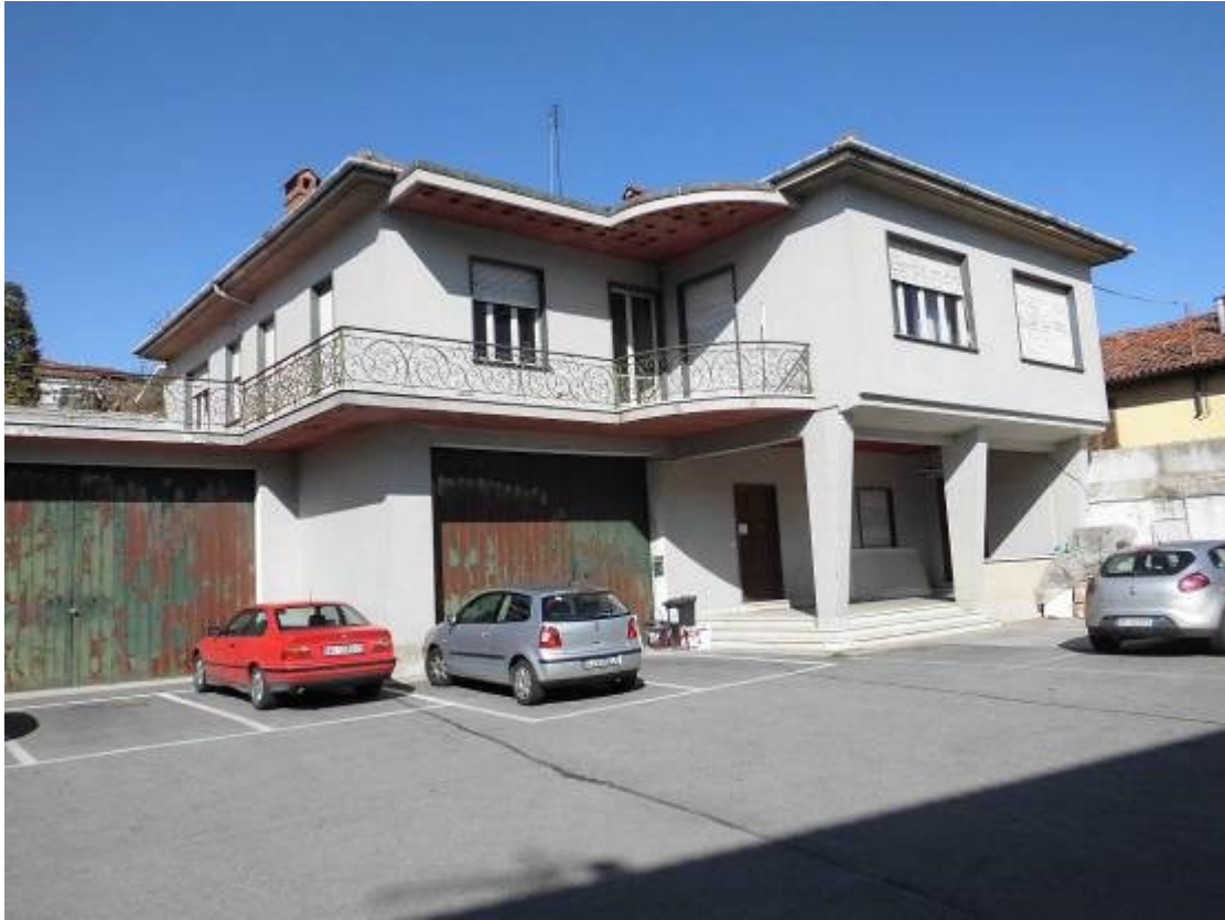
Foto 2 – interno cortile, edificio “villa”. Stato esistente.
