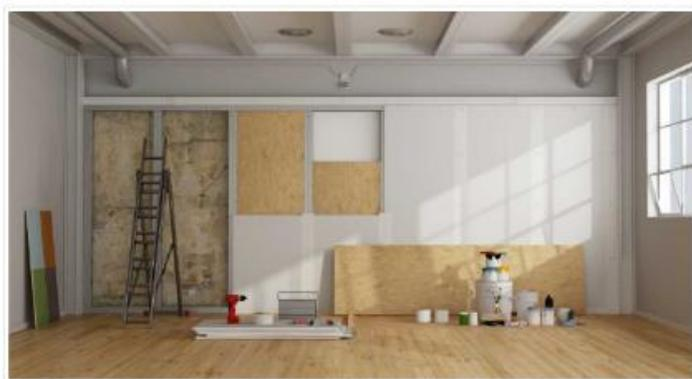
*Isolamento termico interno con pannelli in lana di roccia*
