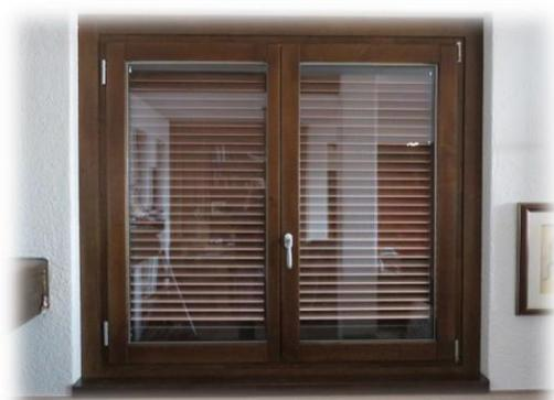
I nuovi serramenti saranno realizzati con telaio in legno e triplo vetro isolante basso emissivo con camera stratificata con intercapedini d'aria.
