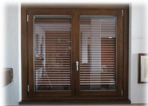
I nuovi serramenti saranno realizzati con telaio in legno e triplo vetro isolante basso emissivo con camera stratificata con intercapedini d'aria.
