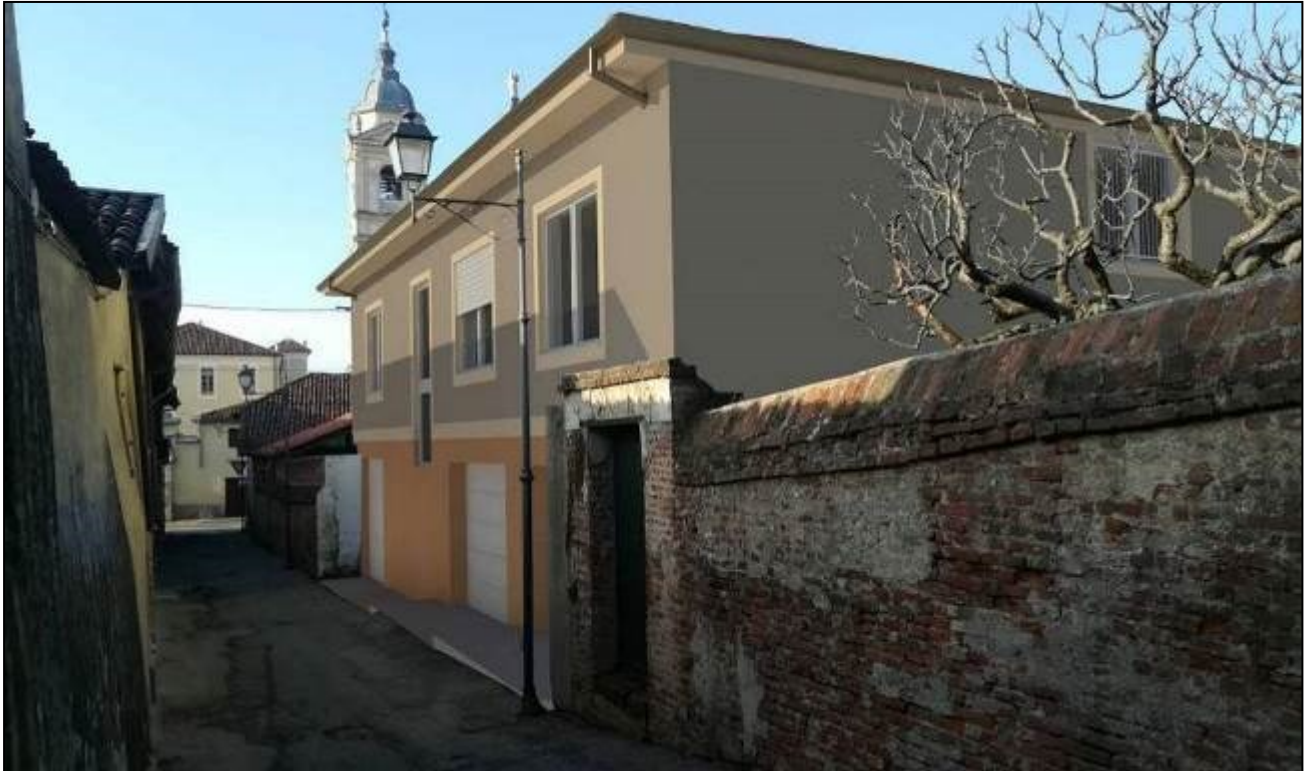
Fotosimulazione 3 – vicolo Santo Stefano, edificio denominato “villa” facente parte del Comparto 2. Stato in progetto. Oltre alla sostituzione della finitura superficiale delle pareti esterne, verranno realizzati degli accessi carrai che consentiranno l’accesso ad autorimesse private poste al piano terreno.
