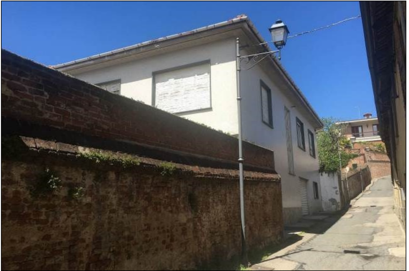
Figura 8 – edificio denominato “villa” visto dal vicolo Santo Stefano.
