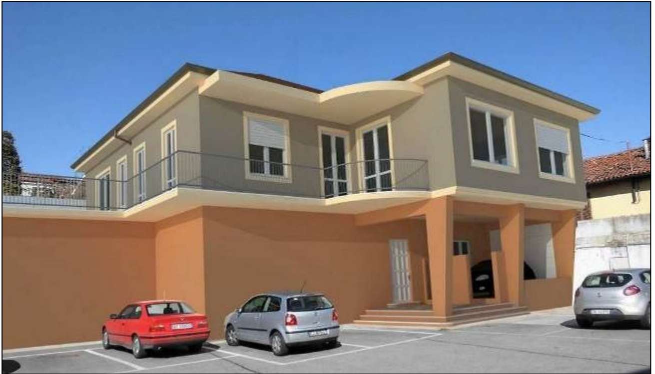
Fotosimulazione 2 – interno cortile, edificio denominato “villa” facente parte del Comparto 2. Stato in progetto. Il progetto prevede di preservare e valorizzare l’edificio. In particolare l’attuale finitura superficiale costituita da elementi in monocottura con effetto mosaico di colore grigio/azzurro, verrà sostituito con un effetto intonaco tinteggiato e verranno riproposti i cromatismi già utilizzati durante l’attuazione degli interventi eseguiti nel Comparto 1.
