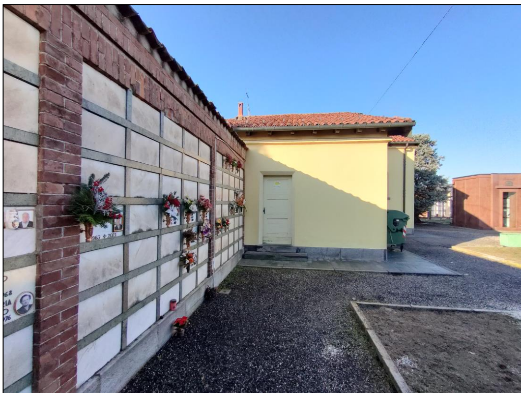
Blocco cellette addossato sul lato interno della recinzione d'ingresso.
