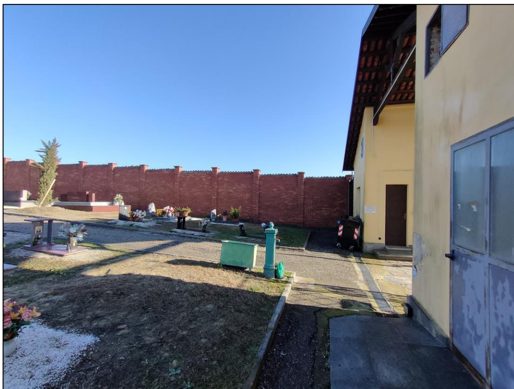
Lato interno dell'edificio di ingresso. Sullo sfondo, la recinzione verso est.
