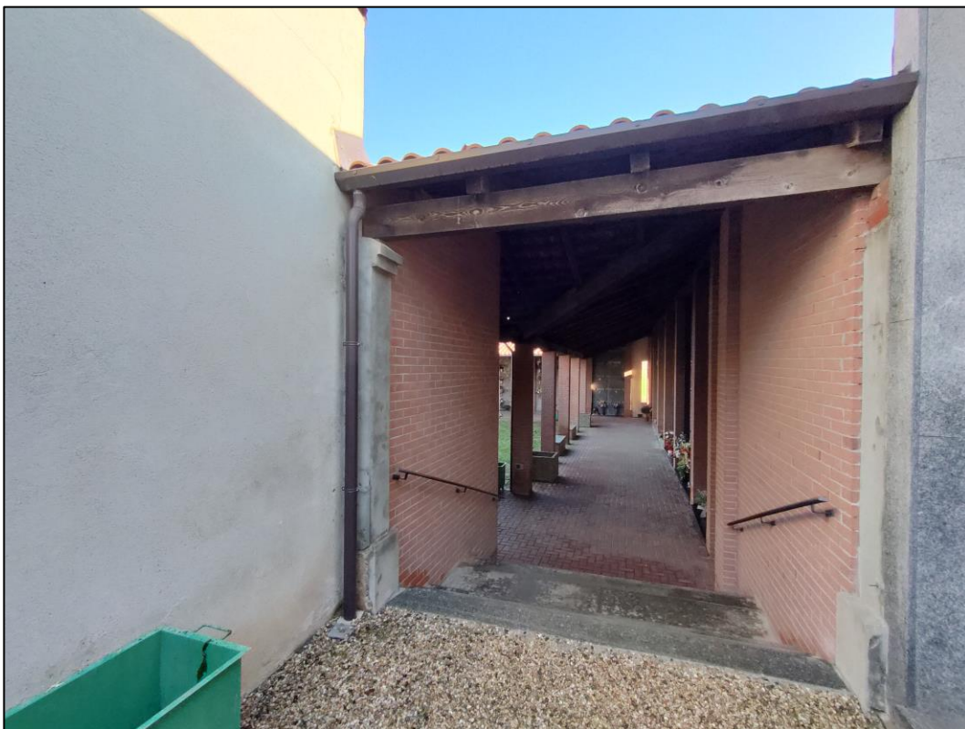
Collegamento tra il cimitero nuovo e quello vecchio con la scala in cemento.
