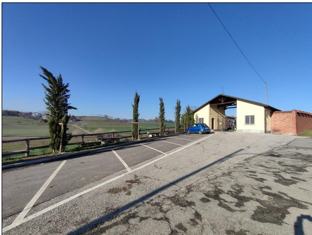
Ingresso del cimitero con il parcheggio frontistante.
