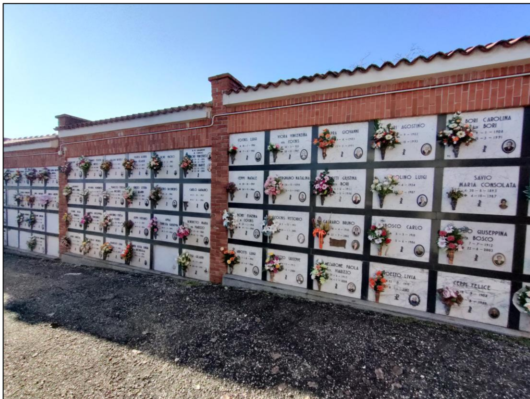
Blocco loculi lungo il lato interno della recinzione verso ovest.
