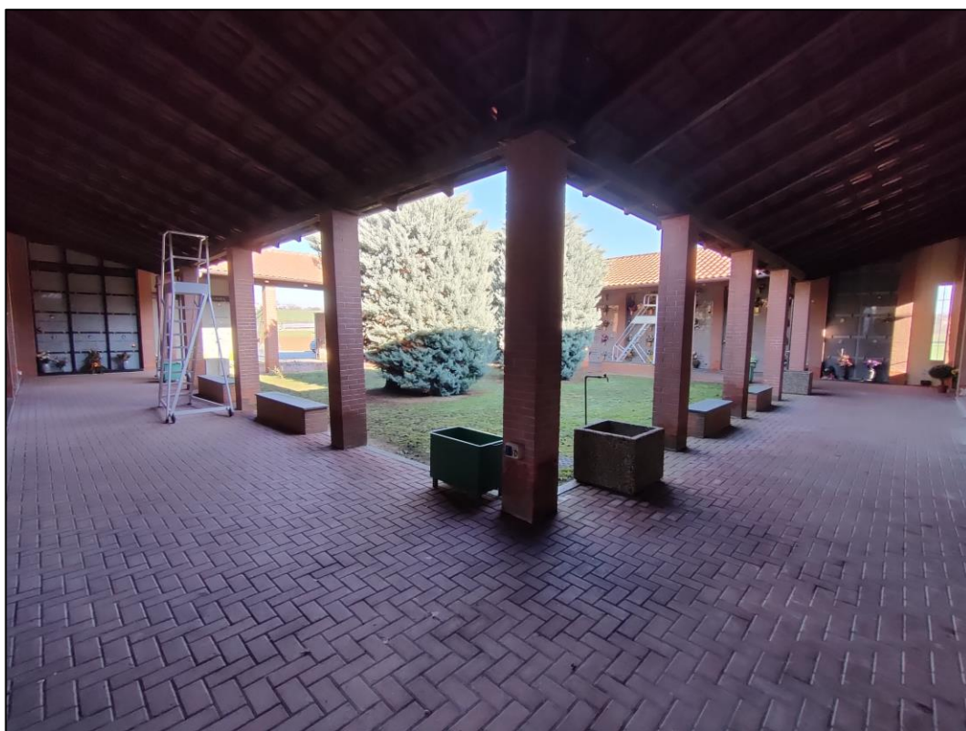
Settore nuovo del cimitero con il quadriportico e l'area verde centrale.
