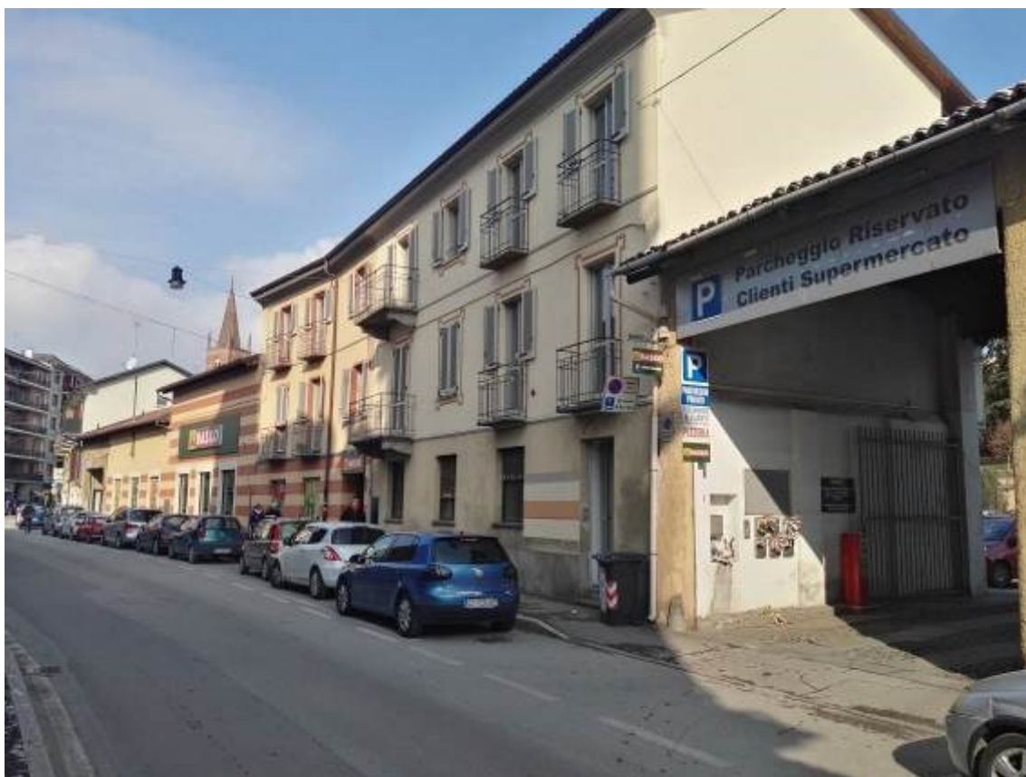
Foto 1 – via Vittorio Emanuele II, edificio a 3 p. f. t.
