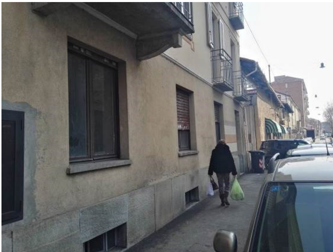
Foto 3 – via Vittorio Emanuele II, edificio a 3 p. f. t.
