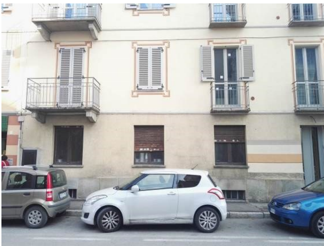
Foto 2 – via Vittorio Emanuele II, edificio a 3 p. f. t.
